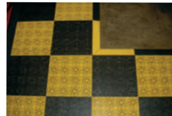
Prethodno sastavljeni paneli 1,2 x 0,9 m
